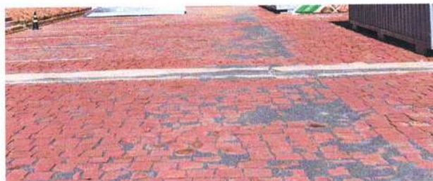
Figura 06– Indicação tipo de piso pedra do pátio
